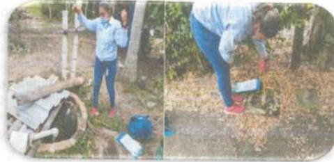
Imagen 15: Control e Aljibes y Freatímetros.
